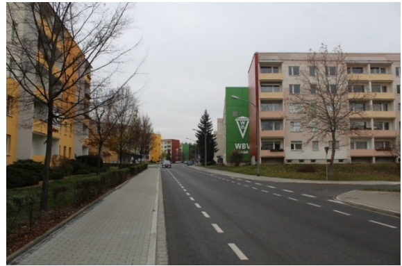
Moritzburger Straße nach dem Ausbau
