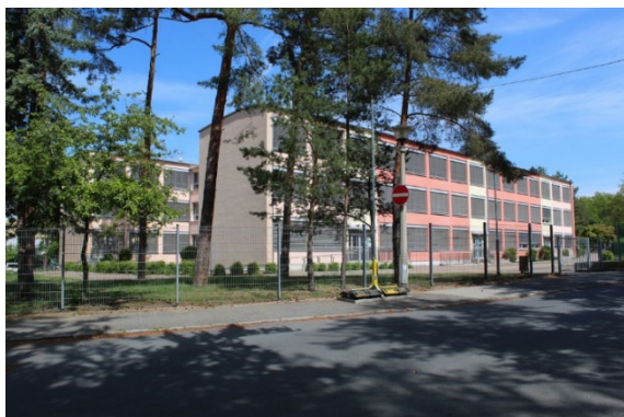
Förderschulzentrum vom Sachsenlaufweg aus
