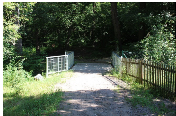
Brücke über den Lockwitzbach (Birkenstr.)
