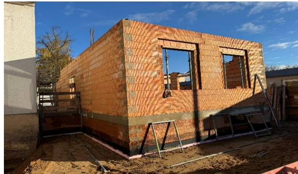
Rohbau des neuen Anbaus
