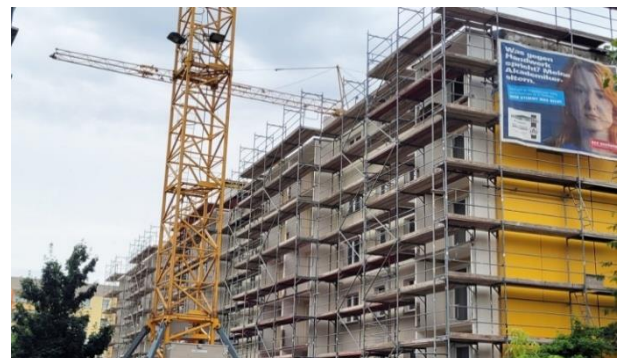
Sanierung Gebäude Moritzburger Straße 75
