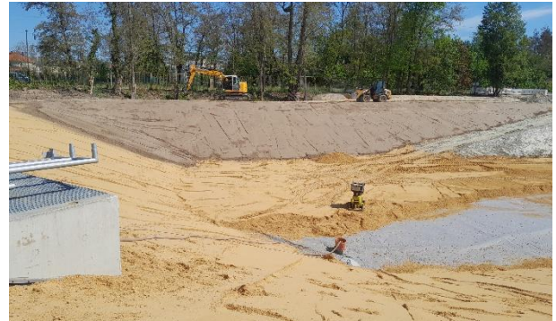
Regenrückhaltebecken im Bau
