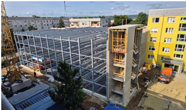
Rohbau Parkhaus Spitzgrund
