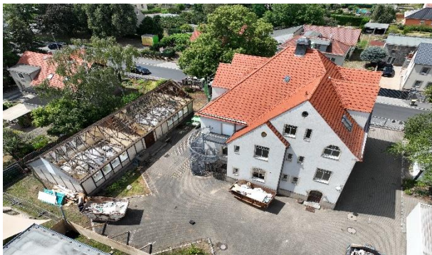
Abriss der Baracke
