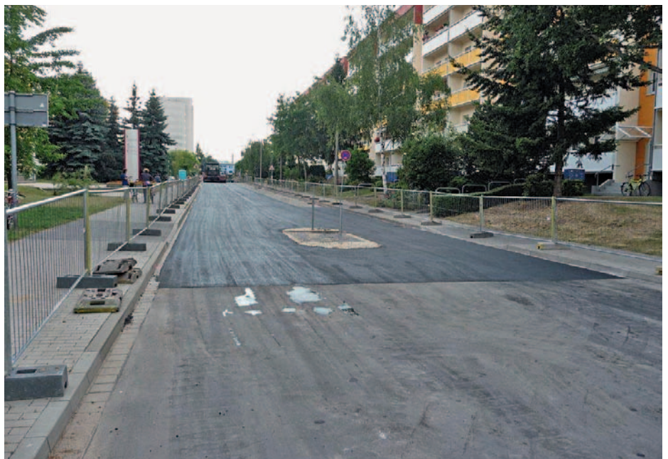
Fußgängerinsel kurz vor Abschluss der Bauarbeiten
