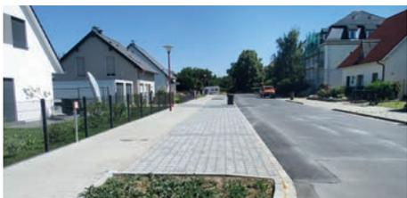
Seit Mitte August wird nun der südliche Gehweg auf der Straße des Friedens von Moritzburger bis Ringstraße auf etwa 85 m Länge neu gebaut. Der vorhandene Weg wird dabei verbreitert, was den Einbau von Winkelstützen erforderlich macht. Für die Oberfläche wird Betonrechteckpflaster verwendet. Anfang Oktober 2019 soll alles fertig sein. Dafür sind ca. 35.000 EUR eingeplant.
