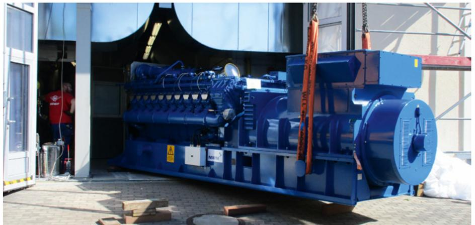
Das Herzstück des Blockheizkraftwerkes, der Gasmotor, gleicht einem großen Schiffsmotor. Bei einer Verbrennungsleistung von ca. 4.000 kW bringt er mehr als 21 Tonnen auf die Waage.
