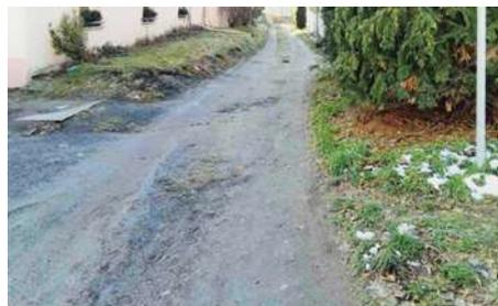
**Brockwitzer Straße:** *Begradigung des unbefestigten Weges, Einbau einer sandgeschlammten Deckschicht sowie Entwässerung*
