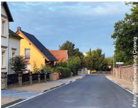
Unter Federführung der WAB GmbH konnten nun endlich die ehemals stark verschlissene Steinstraße auf ca. 350 m Länge ausgebaut und anderthalb Monate früher als geplant, wieder für den Straßenverkehr freigegeben werden. Aufgrund der Neuverlegung von zwei Kanälen und einer Trinkwasserleitung ist von der Fahrbahn nicht mehr viel übriggeblieben, auch die Bordsteine sowie Gehwege wurden saniert. An diesen Maßnahmen hat sich die Stadt Coswig finanziell (ohne weitere För-
