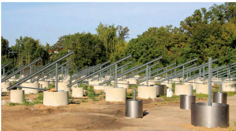
Die Technischen Werke Coswig GmbH freuen sich, den Beginn des Baus einer neuen Solarthermieanlage im Spitzgrund bekanntzugeben, die eine Kollektorfläche von ca. 2.782 m<sup>2</sup> auf einer Grundfläche von 5.400 m<sup>2</sup> umfassen wird. Diese innovative Anlage wird mit insgesamt 228 Vakuumröhrenkollektoren ausgestattet, die jeweils aus 78 Röhren bestehen und insgesamt eine Gesamtleistung von 1,1 Megawatt erreichen.
