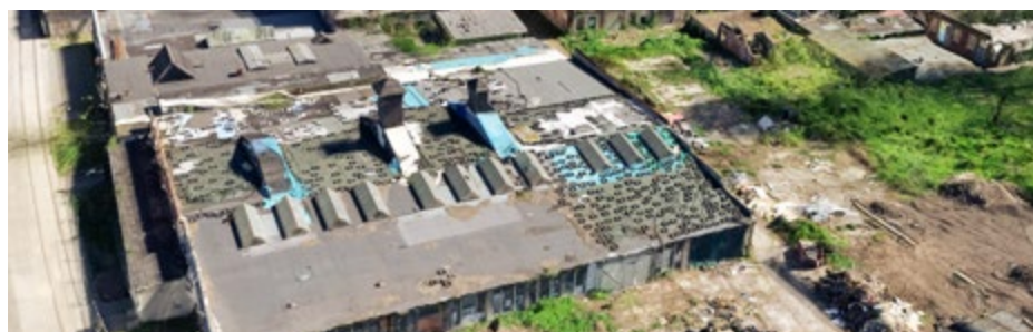
Altes Cowaplastgelände vor der Abriss- und Bauphase im Jahr 2023
