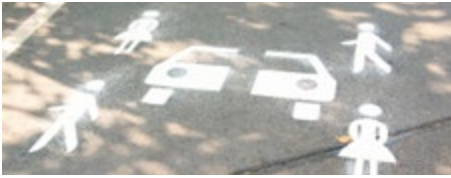
Bodenmarkierung von Carsharing Stellplätzen
