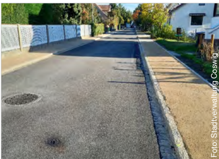
Der fertige erste Bauabschnitt der Gartenstraße
