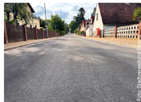
Umfangreiche Infrastrukturarbeiten in der Gartenstraße: Neben dem Kanalbau wurden Trinkwasserleitungen, Strom- und Breitbandanschlüsse erneuert sowie die Straße grundhaft ausgebaut
