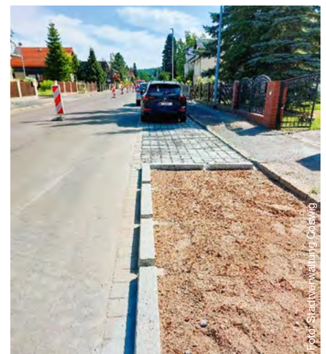
Nachhaltige Gestaltung der Auerstraße: Die neuen Parkstreifen wurden mit wasserdurchlässigem Fugenpflaster befestigt und Bauminselfen für eine bessere Begrünung und ein angenehmes Stadtklima angelegt
