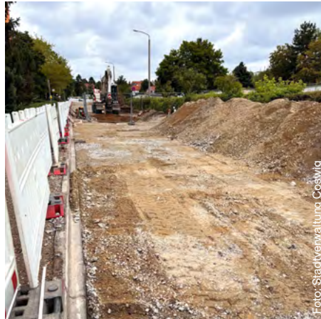
Die alte aufgefärschte Betondecke wird aufbereitet und als Unterbau für die neue Fahrbahn wiederverwendet
