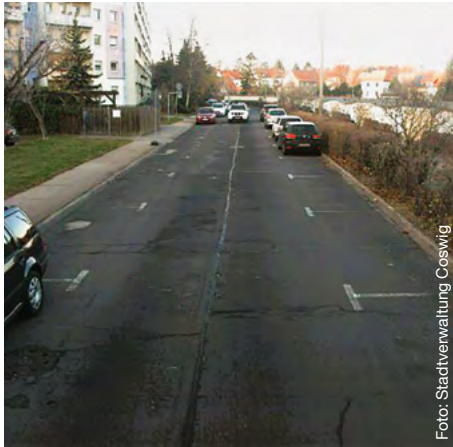
Vor Beginn der Baumaßnahme
